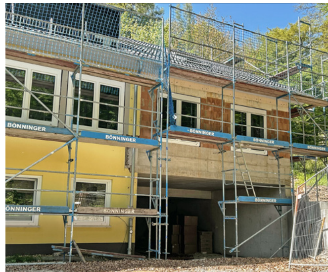
Das Haupthaus wurde im Jahr 2025 aufwendig saniert.
